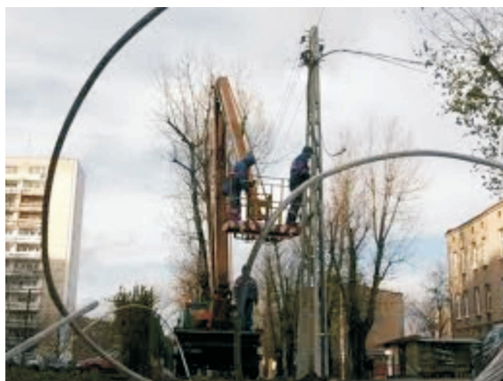
Zerwane linie energetyczne
